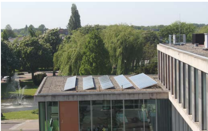
Zonnepanelen op dak gemeentehuis, initiatief Zon op Zwijndrecht.
