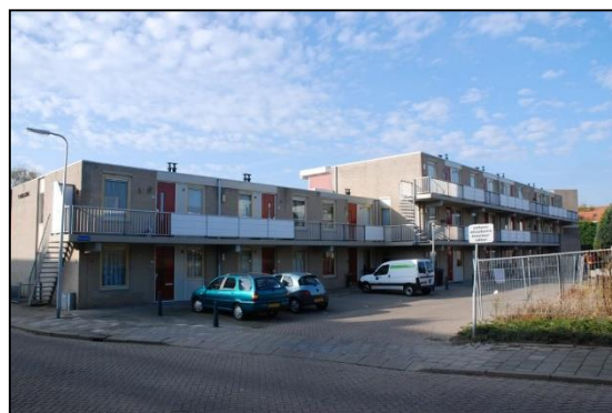
Woningen aan de Perenhof.
