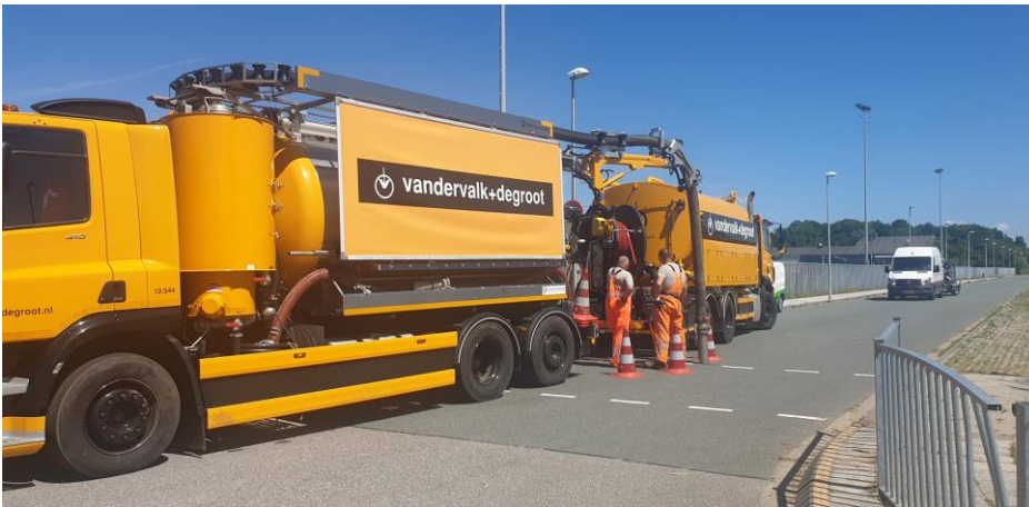
Figuur 6-1 Rioolreiniging Voltastraat
