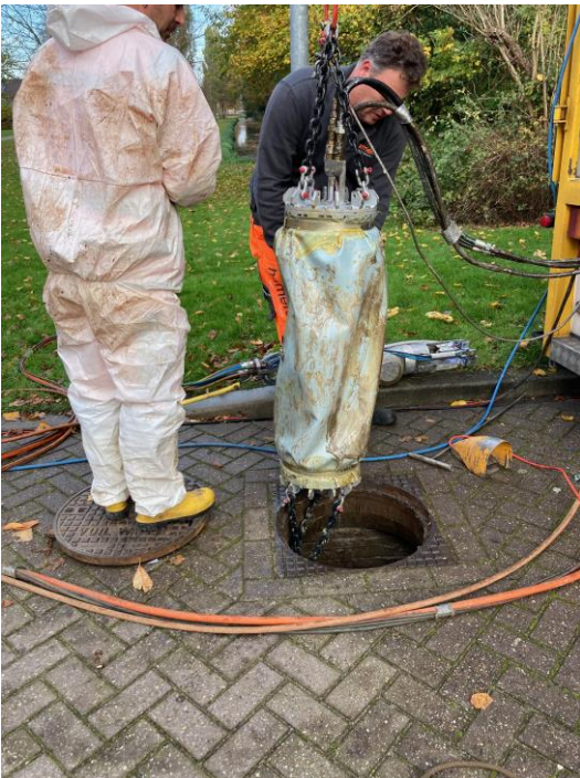
Figuur 0-2: Plaatsing van een deekous aan de Schoutweg
