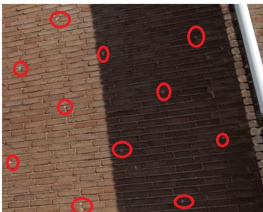
Foto 5: overzicht gevel school, met vulgaten van de na-isolatie
